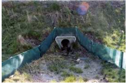
Figura 36.- Malla de material plástico y alcantarilla para anfibios y pequeños mamíferos
