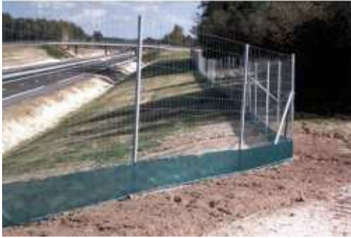
Figura 36.- Malla de material plástico y alcantarilla para anfibios y pequeños mamíferos
