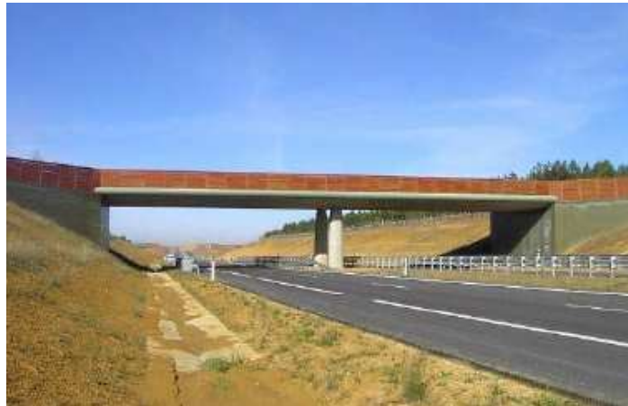
Figura 34.- Paso superior de fauna en Castilla y León (Pk. 66.570)
