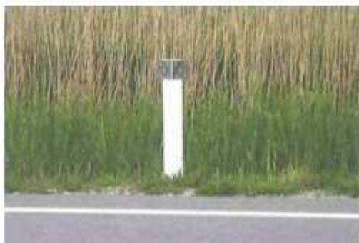
Figura 22.- Ejemplo de reflector de alerta para jabalí y cérvidos. (Foto de C. Rosell). [Fuente: Ministerio de Medio Ambiente]
