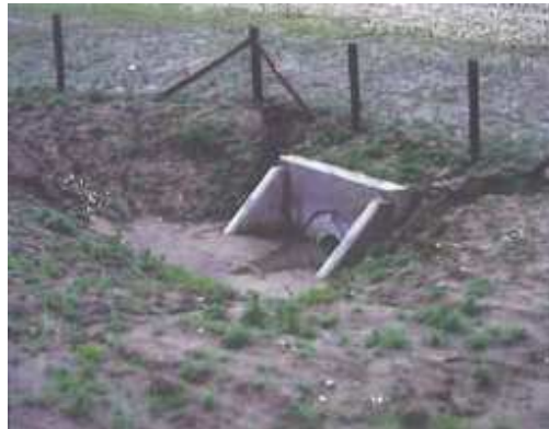
Figura 40.- Este paso ha quedado parcialmente inundado y colmatado con arena. La lección aprendida de este ejemplo es que los pasos deben estar contruidos por encima del nivel del acuífero y que sus accesos deben tener pendientes estables, que no puedan resultar afectadas por la erosión. (Foto de H. Bekker). [Fuente: MMA]
