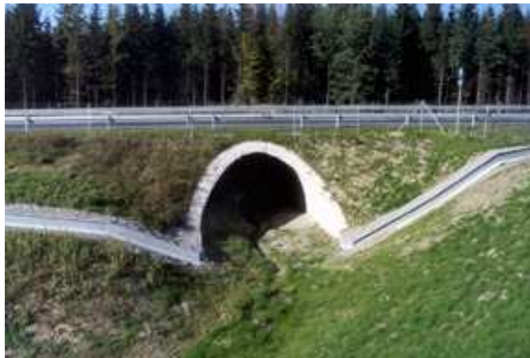
Figura 37.- Alcantarilla en la autopista alemana B-30, con un rail para anfibios y una valla para la fauna de mayor tamaño
