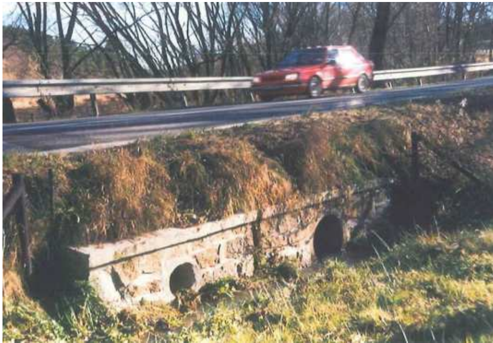
Figura 41.- Las nutrias no utilizan pasos completamente inundados. Si usan, en cambio, pequeños tubos paralelos a los drenajes pero situados por encima del nivel del agua, como estos que cruzan por debajo de una carretera del sureste de la República Checa. (Foto de V. Hlavác). [Fuente: MMA]
