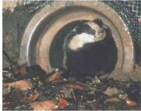
Figura 39.- Pequeño paso inferior de fauna, utilizado por un tejón. Esta estructura también puede ser útil para otros mustélidos, micro mamíferos y anfibios. El diámetro de los pasos para tejones construidos en este país oscila entre 0,3 y 0,6 m, y su longitud entre 5 y 10 m. (Foto de Verenigin 'Das en Boom'). [Fuente: MMA]
